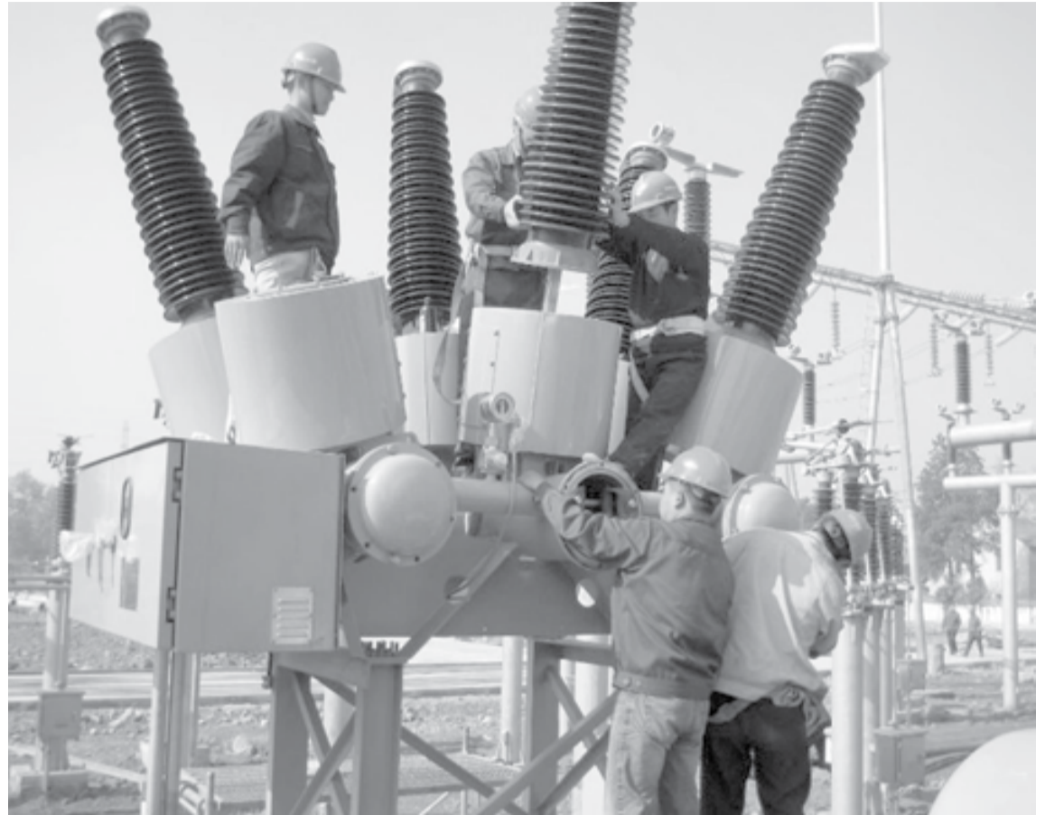
2. Interruptor de energía eléctrica para alto voltaje empleando SF 6 para extinguir los arcos eléctricos. De no emplear dicho gas, el sistema tendría que ser mucho más grande.
