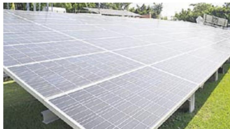
**Sistema Fotovoltaico de 9kWp del IER-UNAM.**
