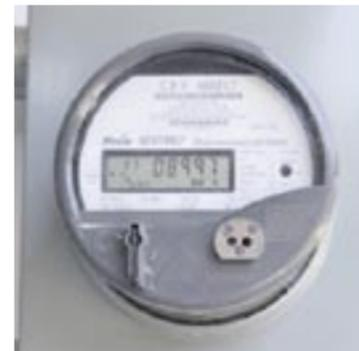
**Medidor de "Dos Vías" para la interconexión con la red.**
